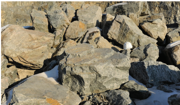
Heavy Stone Fill
